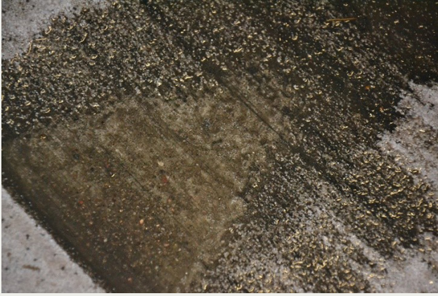
Figur 2. Akryl Silikal Dekor efter 4 år på parkeringsdäck Åkeshov. Slitage ner till betongen efter burnouts.
