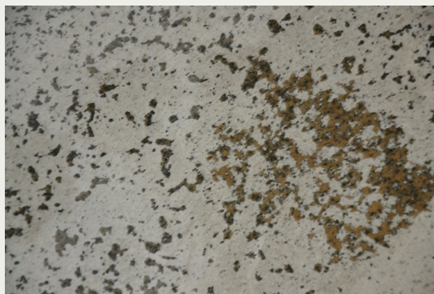
Figur 1. Slitage på Polyuretan Mapeifloor PU efter 5 år på parkeringsdäcket i Kville.
